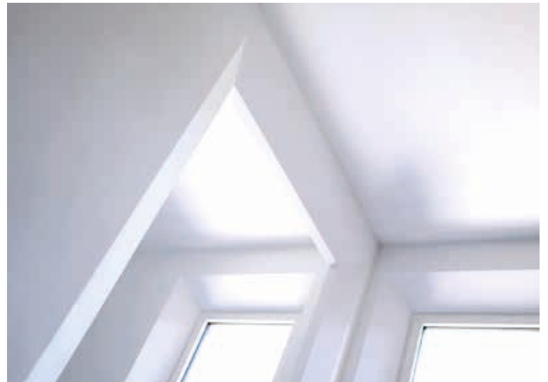
Perfect gepleisterde overgangen
