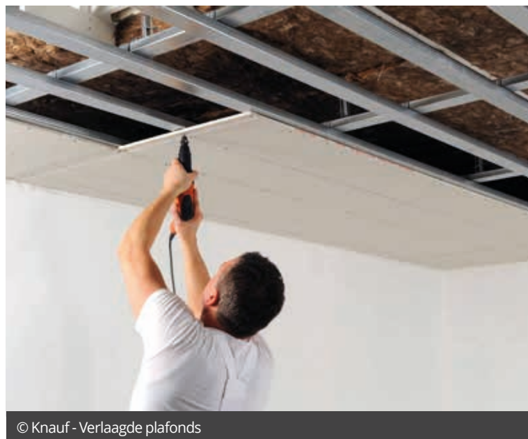
Een correcte afwerking voorkomt akoestische lekken
