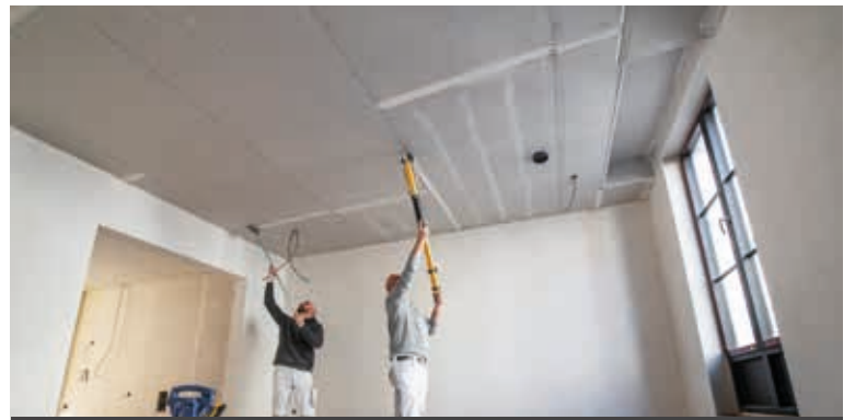
Q-niveaus en gereedschappen in gipsplaatafwerking
