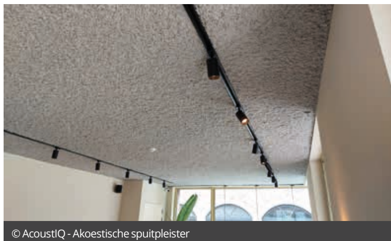
© J. Kuhnert - Realisatie met geluidsabsorberende pleister
