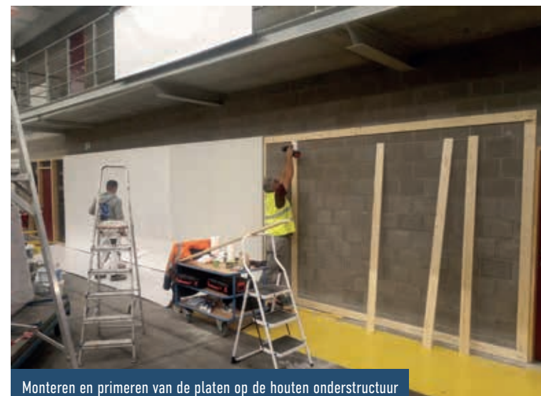
Monteren en primeren van de platen op de houten onderstructuur
