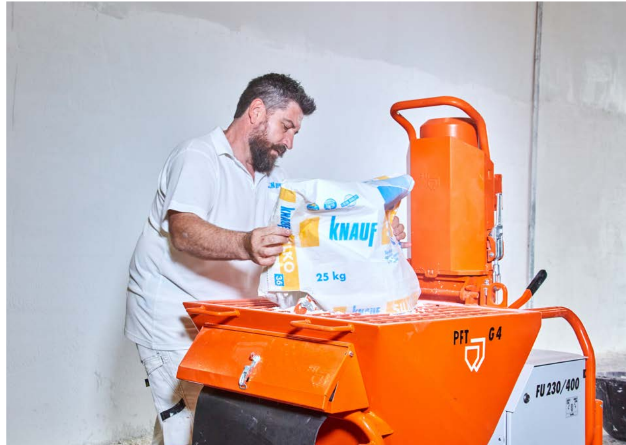
© Knauf - De spuitmachine verwerkt pleister tot een standvastige consistentie en kwaliteit
