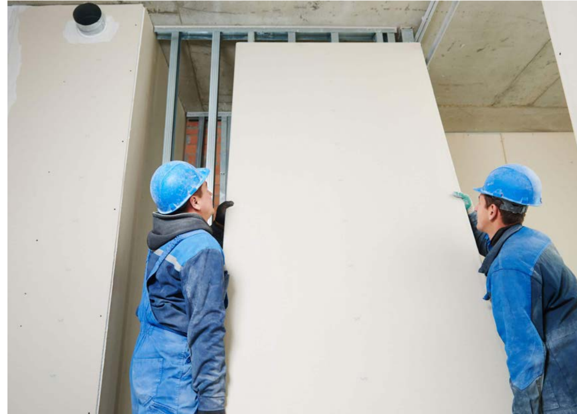
Plaatsen van geluidsisolerende wand
