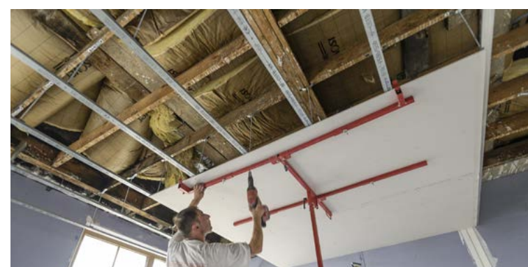
Techniek: plaatsen van een afgehangen plafond
