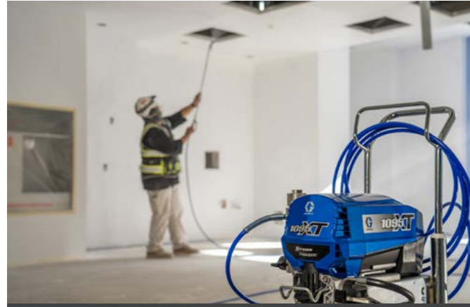
© Graco – Airless-systemen werken onder zeer hoge druk
