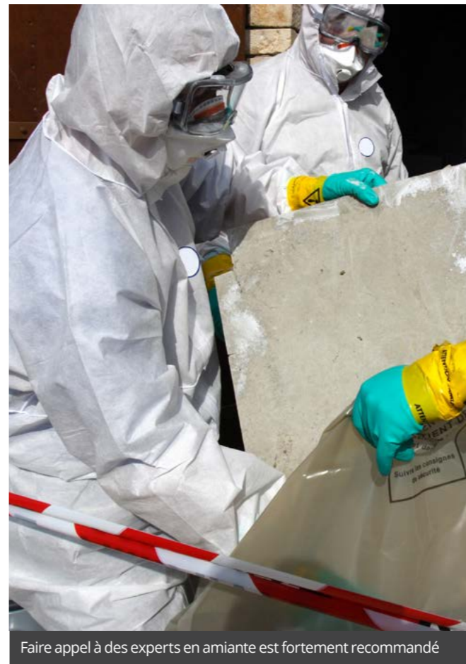
Si vous avez du plâtre contenant des fibres d'amiante, celles-ci ne sont pas fortement liées au matériau
