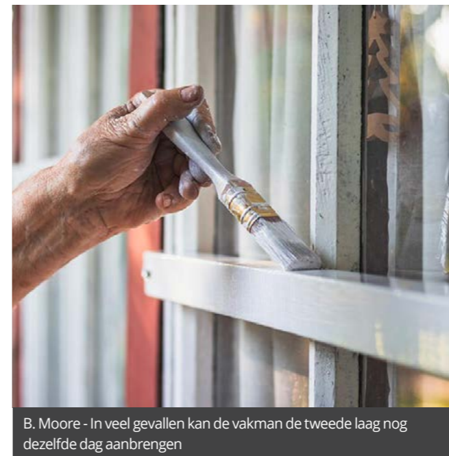
Homeguide - Het water van watergedragen lakken verdampt na de applicatie en dringt niet door in het hout
