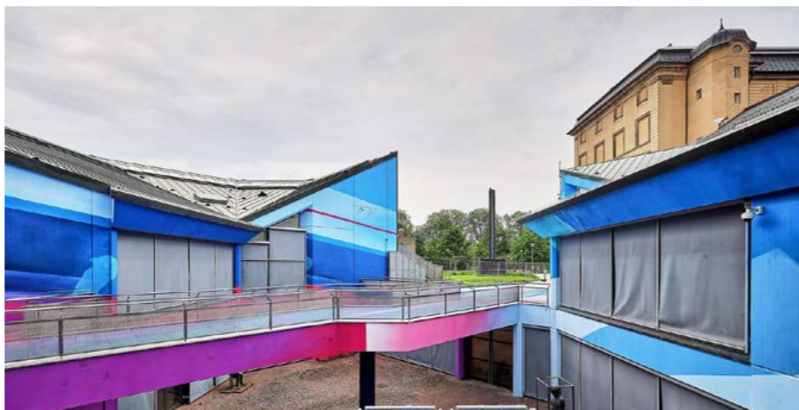
De verf beschermt het metselwerk tegen regenwater en vocht en, dankzij de filmconservering, tegen algen en schimmels
