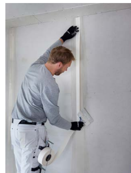
© Dalapro - Dalapro Joint in combinatie met een papieren voegband geeft een enorm sterke voeg
