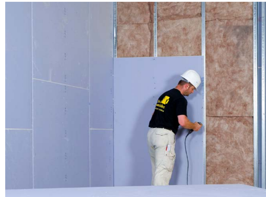
Knauf - Voorzetwanden zijn net zo brandwerend als scheidingswanden
