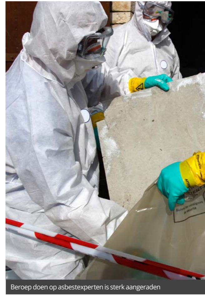
Als er asbestvezels in het stucwerk verwerkt zijn, liggen deze vezels niet sterk gebonden in de pleisterlaag
