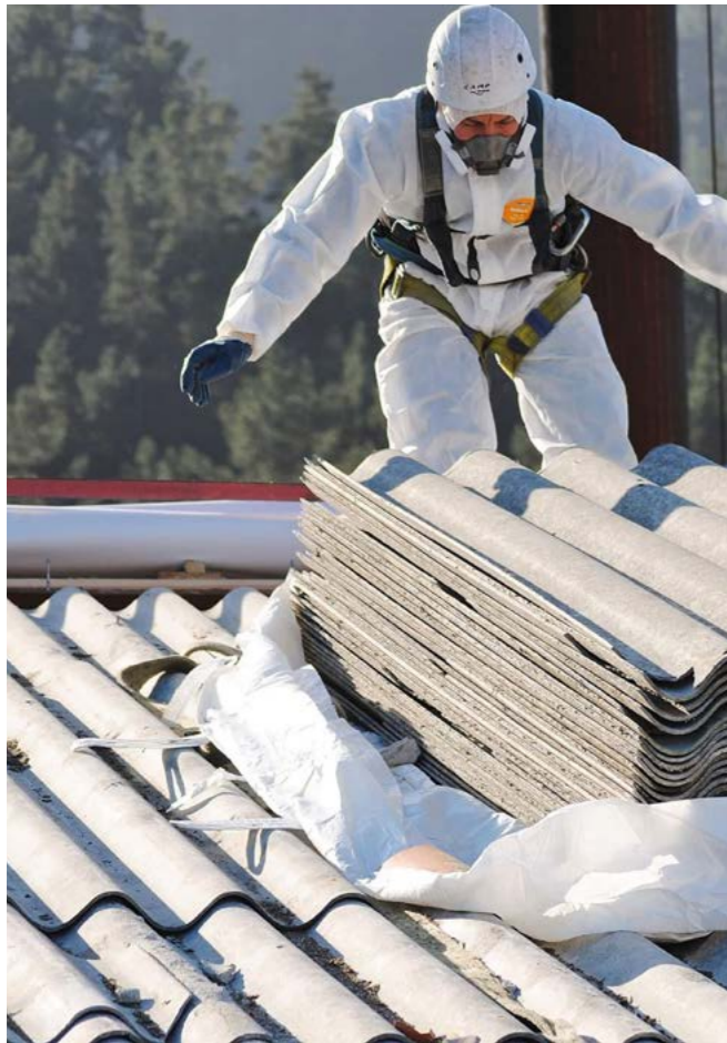
Op plaatsen waar het materiaal gebroken of verweerd is, kunt u asbestvezelbundels vaak met het blote oog zien
