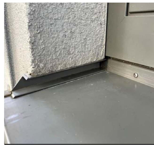
Xthermo - Pas de raccord étanche à l'eau avec la menuiserie
