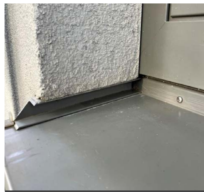
Xthermo - Geen waterdichte aansluiting met schrijnwerk
