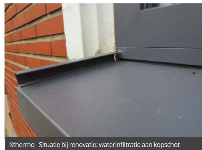
Xthermo - Geen waterdichte aansluiting met schrijnwerk
