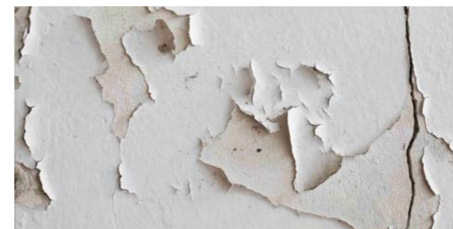
Barsten, schilferen, afpellen, ... is doorgaans te wijten aan applicatie bij een te hoge of te lage temperatuur
