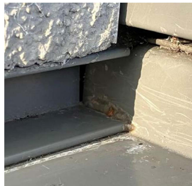
Xthermo - Detail van een niet waterdichte aansluiting
