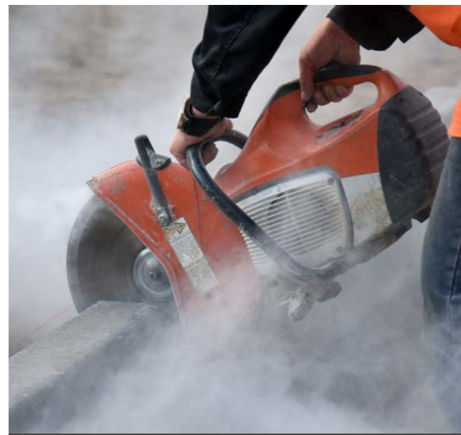
© Shutterstock - In de bouwsector wordt veel gewerkt met materialen die kwartsstof bevatten
